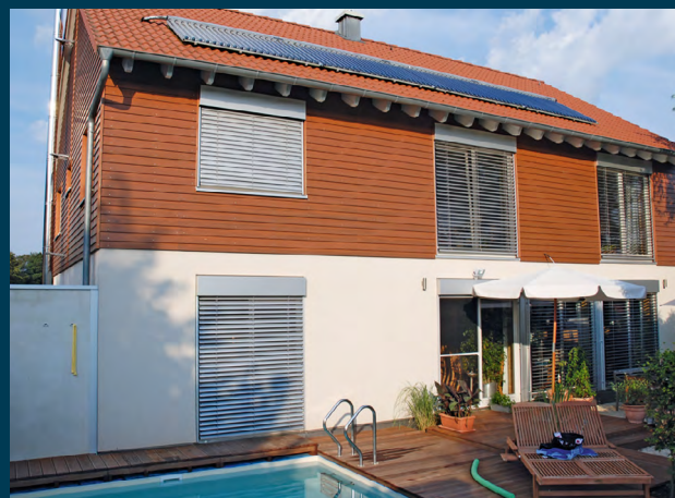
Einfamilienhaus mit BIOCAT KS 3000 Kalkschutzgerät
