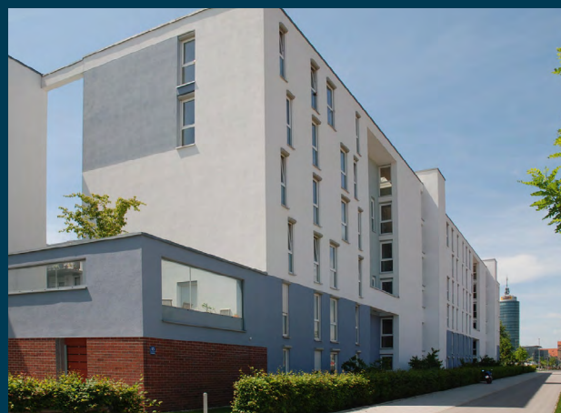
Wohngebäudekomplex im Max-Friedländer-Bogen in München mit BIOCAT KS 14000, ausgelegt für 110 Wohneinheiten
